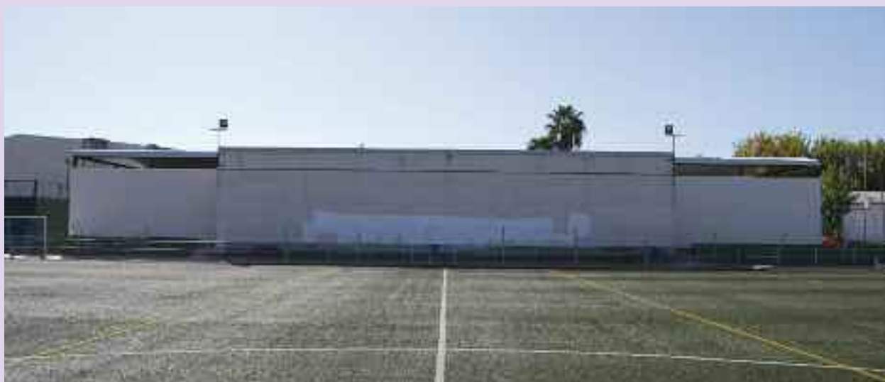
Ampliación del gimnasio.
